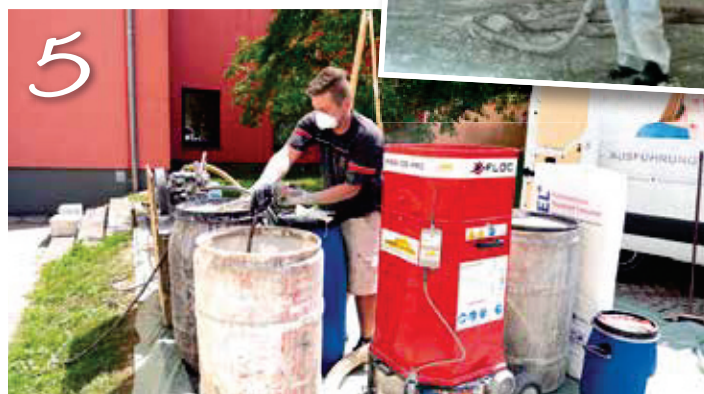
Mischen des Spritzputzes im Freien
