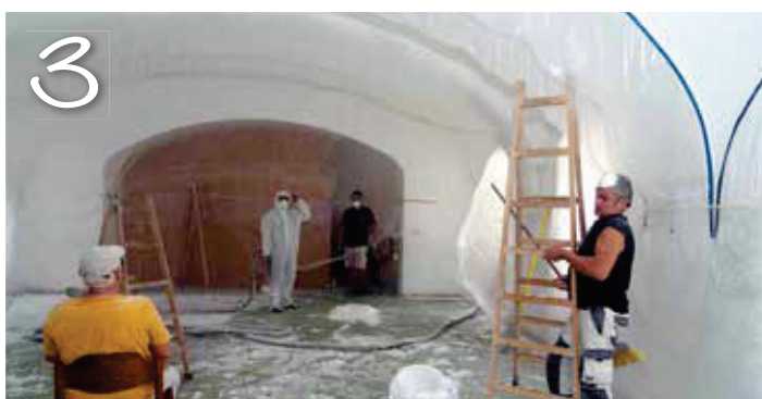
Kurze Spritzpause, Umstellen der Leitern und Zwischenreinigung
