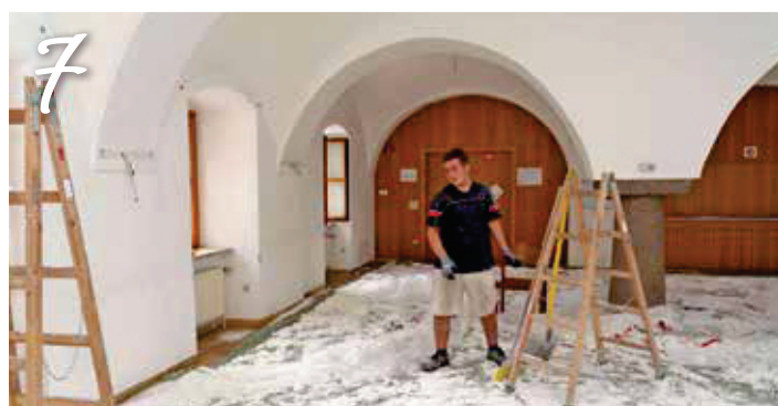
Fertig, alle Wände frei, nur noch der „Schnee“ liegt am Boden
