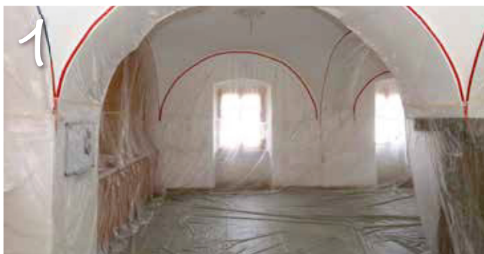
Vor Aufbringen des Putzes wurden alle Kanten exakt abgeklebt und alle nicht zu verputzenden Flächen (Wände, Fenster, Boden, Säulen, Gewölbegurte, etc.) hermetisch abgedeckt
