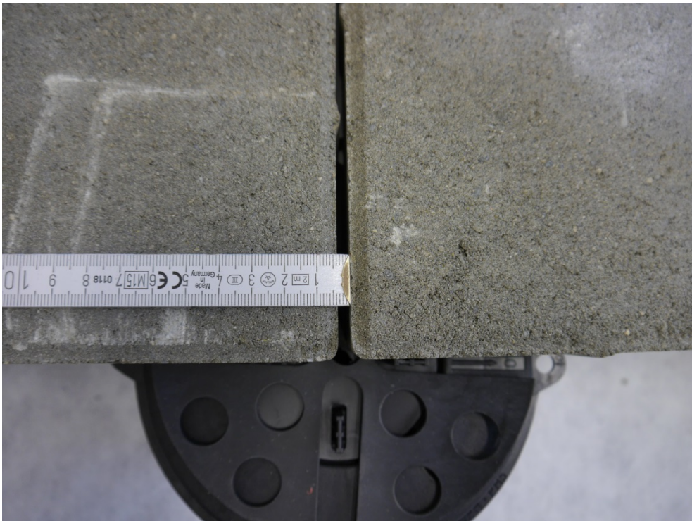
Abbildung B.4. Prüfaufbau während der Montage: Auflagerdetail der Betonplatten auf einem Stelzlager.
