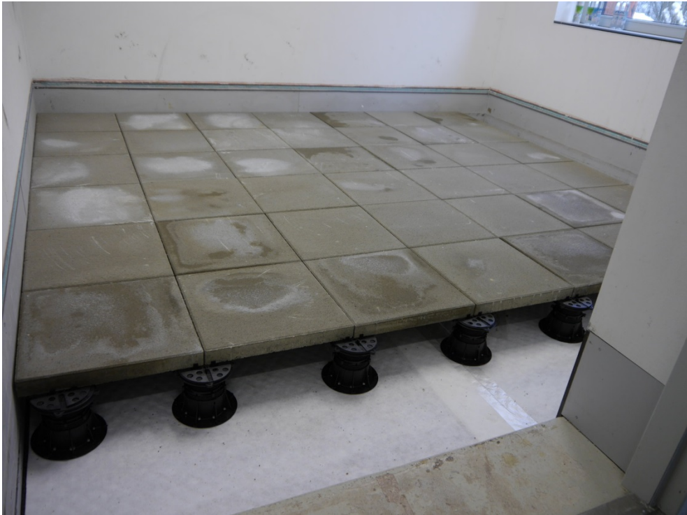
Abbildung B.5. Prüfaufbau im Deckenprüfstand: prüffertig.
