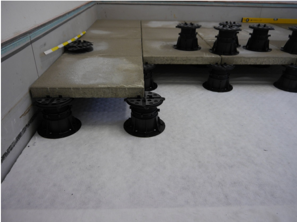
Abbildung B.3. Prüfaufbau während der Montage: Betonplatten auf Stelzlager.
