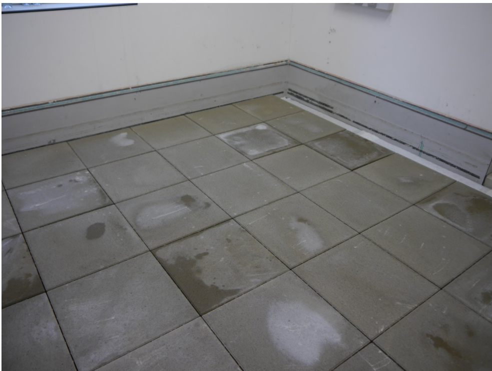
Abbildung B.6. Prüfaufbau im Deckenprüfstand: prüffertig.
