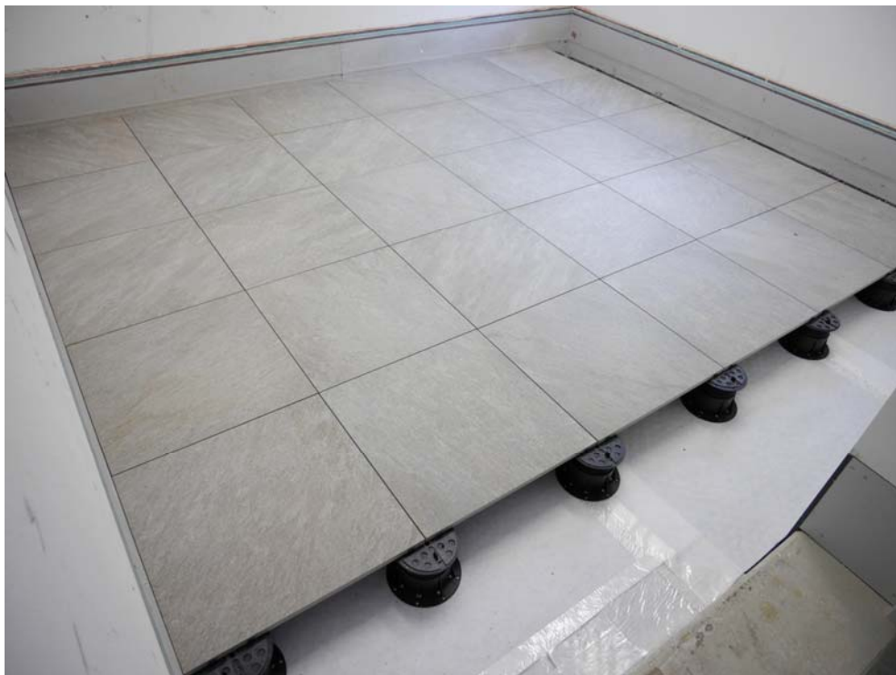
Abbildung B.6. Prüfaufbau im Deckenprüfstand: prüffertig.
