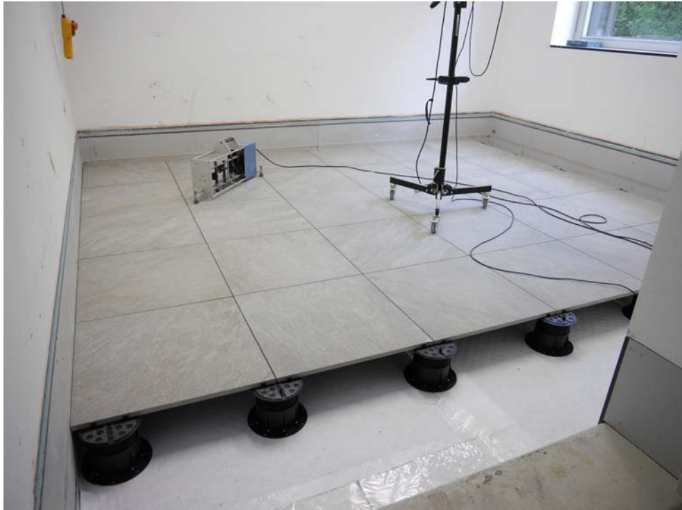
Abbildung B.5. Prüfaufbau im Deckenprüfstand: prüffertig.
