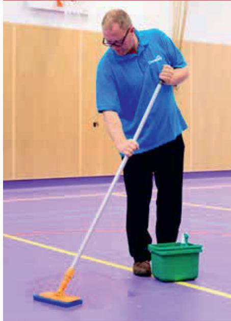
Verschmutzung mit einer schrubbenden/kreisenden Bewegung bearbeiten. **Wichtig:** Zu starkes Scheuern kann den Boden beschädigen. Benutzen Sie immer ein weiches Mopp-Pad.
