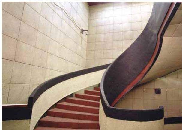
Die Schießanlage der GSG 9 in Hangelar: komplette Verkleidung mit **Regupol®** Elastikplatten E43.
