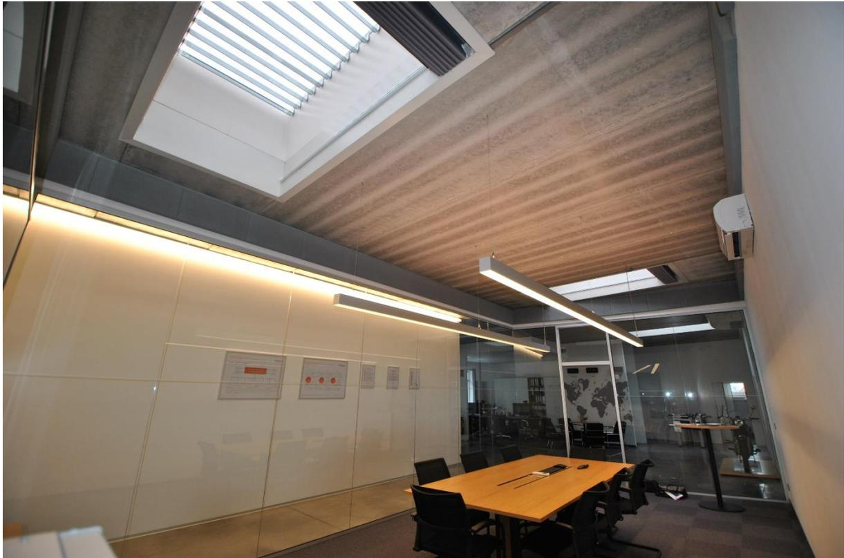
Die Fläche des Büros sind ca. 31 m<sup>2</sup>. Der Ringabsorber wurde vertikal am oberen Rand der Wände zur Decke hin montiert. Die Fläche des Ringabsorbers sind ca. 7,24 m<sup>2</sup>.
