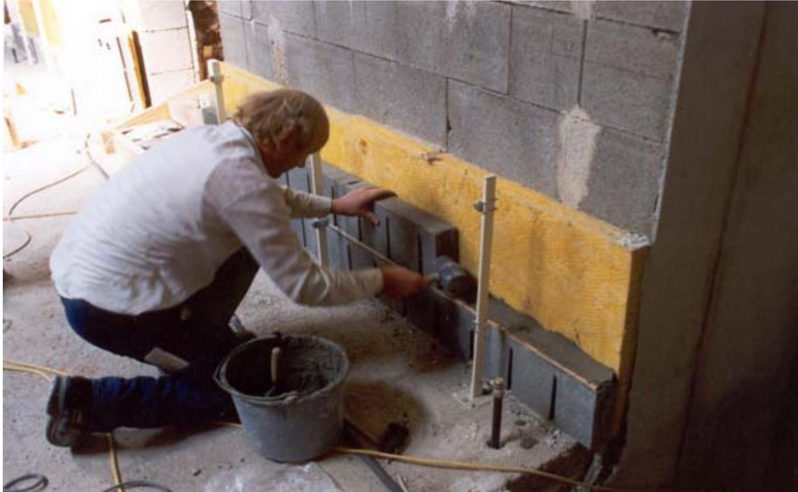
Hier ist ersichtlich, dass auch Steckdosen und Verkabelungen einwandfrei in den Acoustic-Block eingearbeitet werden können.
