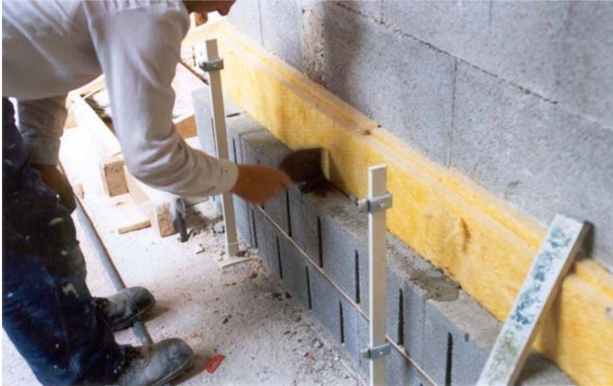
**Bohren der Löcher für die Luftschichtanker**
