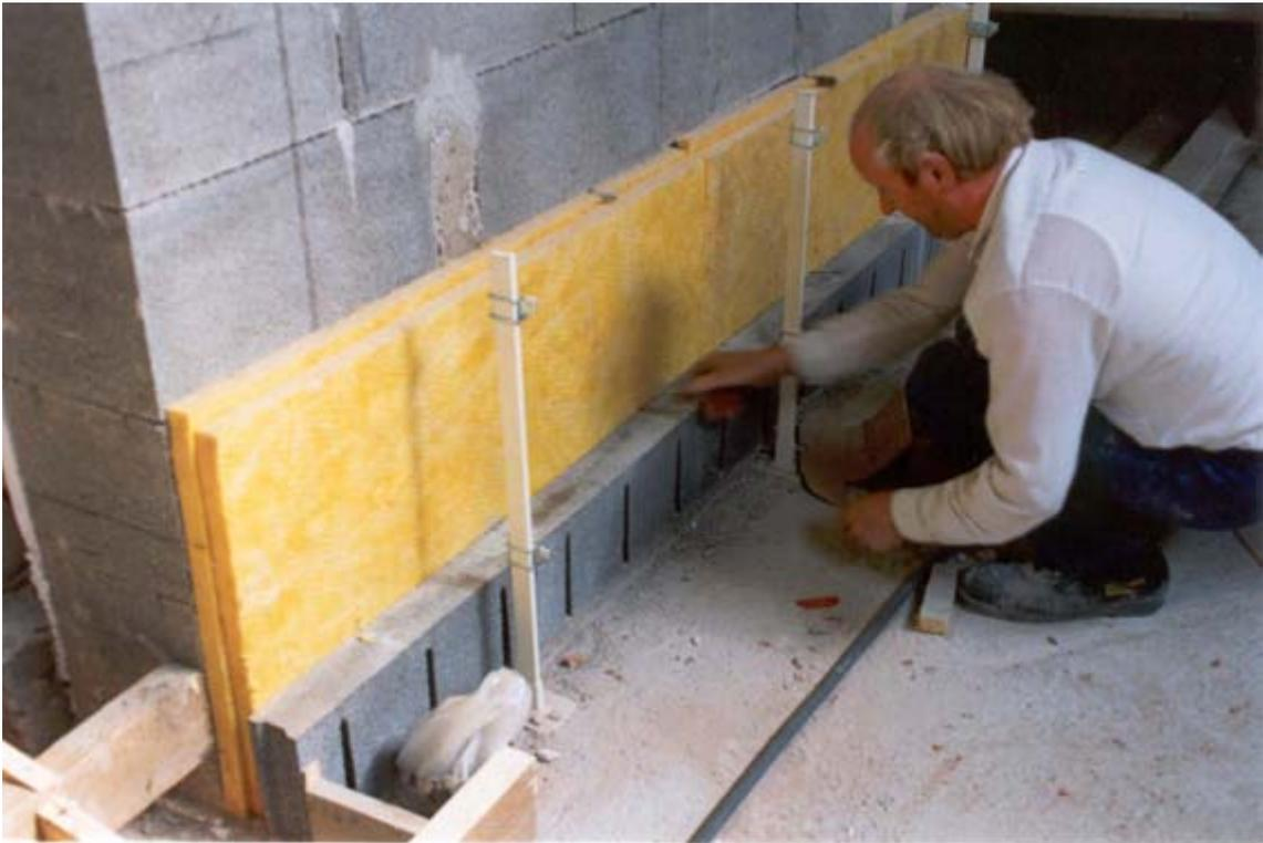
**Abwinkeln der Luftschichtanker**
