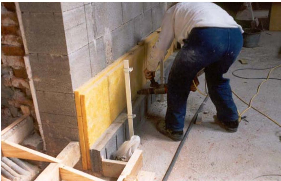
**Einsetzen der Dübel und Stahlanker**
