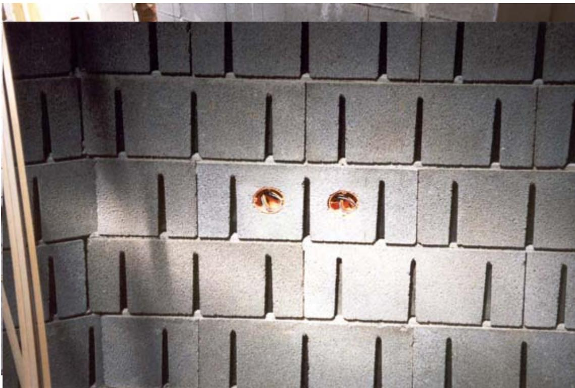
**Fertiggestellte Acoustic- Block – Betonkammern – Wand**
