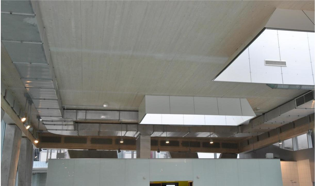
Die Montage erfolgte per Seilabhänger umlaufend auf beiden Seiten der Deckenträger.
