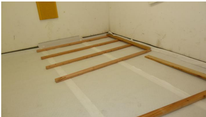
Regupol sound and drain, Dicke 15 mm, ausgelegt auf Bitumenschweißbahn, Vorbereitung der Lattung
