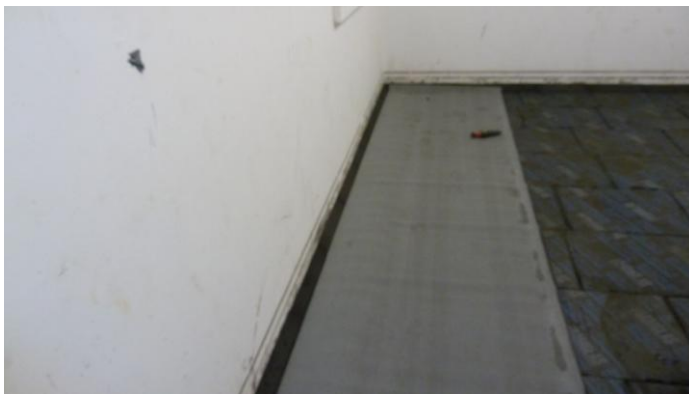
Foamglas T4 mit Bitumen-Unterlagsbahn, Dicke 4 mm (Oberlagsbahn, Dicke 5 mm)
