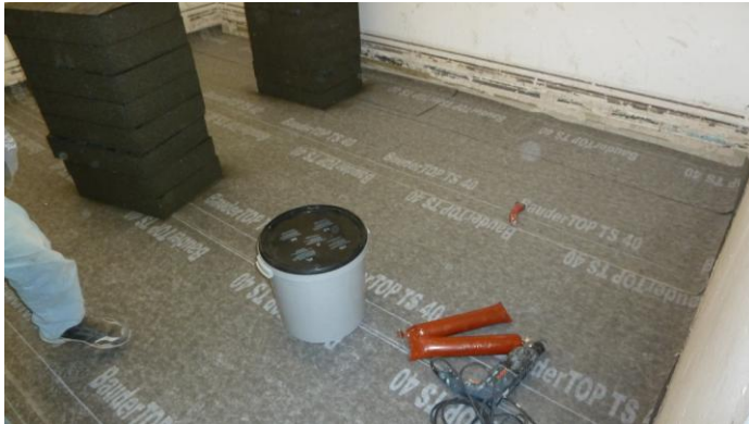
Verlegung der „Notabdichtung“ auf die Rohdecke
