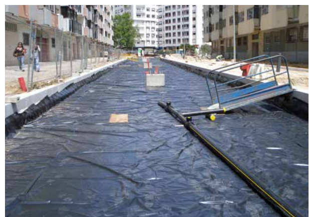
Die Verlegung von Regupol® SB 16/100 prof , eine bewährte elastische Zwischenschicht für leichte Masse-Feder-Systeme, in Almada, Portugal.
