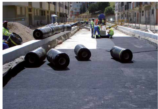
Die Verlegung von Regupol® SB 16/100 prof , eine bewährte elastische Zwischenschicht für leichte Masse-Feder-Systeme, in Almada, Portugal.
