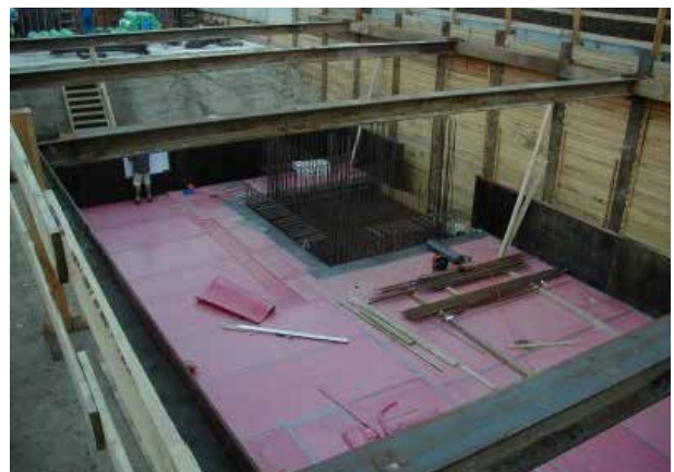
Vollflächige Entkopplung eines Gebäudefundamentes mit Regupol®/Regufoam® Schwingungsdämmmaterial: 1 Natürlicher Untergrund • 2 Impedanzplatte • 3 Regupol®/Regufoam® Schwingungsisolierung • 4 Fundamentplatte • 5 Kellerwand • 6 Geschossdecke
