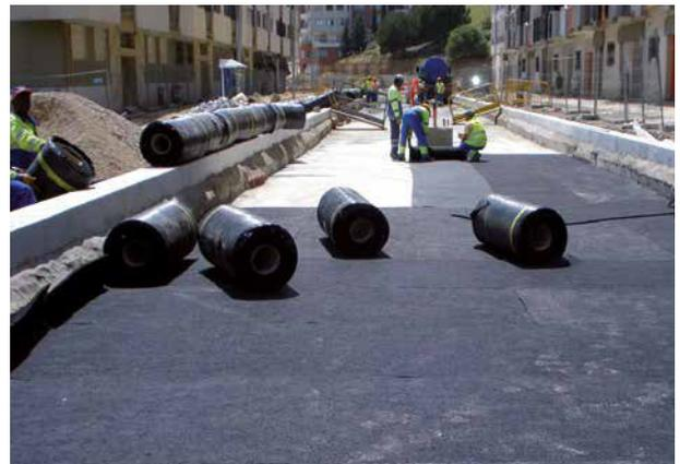
Die Verlegung von **Regupol® SB 16/100<sup>prof</sup>**, eine bewährte elastische Zwischenschicht für leichte Masse-Feder-Systeme, in Almada, Portugal.
